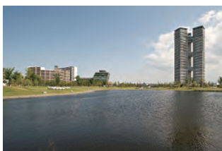
アイランドシティ中央公園から 外観を望む
